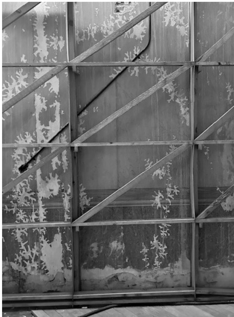
Det, der gemmer sig bag væggene i Børsgangen: bemalede overflader og detaljer - og installationer. Foto: Merete Lind Mikkelsen
