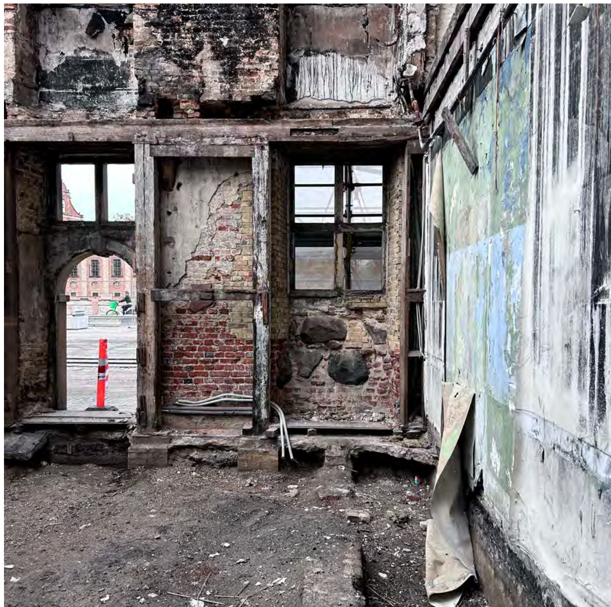
Den oprindelige struktur i Børsen står blottet efter branden og i stor kontrast til de nye, næsten scenografiske tilføjelser. Her ses det oprindelige skillevægsgfundament og de fint proportionerede vindues- og døråbninger i facademuren. Foto: Merete Lind Mikkelsen
