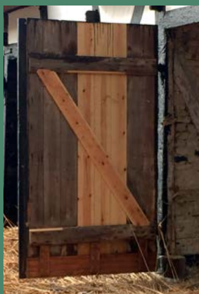
Mindre skader på revleportens fløj er repareret (til venstre). Man kan være heldig at finde genbrugte messinggreb (til højre).
