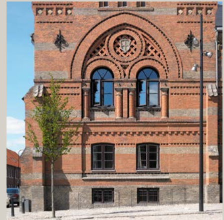
Mange offentlige bygninger blev opført med murede detaljer af ufatteligt høj kvalitet. Fredericia Rådhus, 1860, er bygget af røde og gule sten og rigt dekoreret mønstermurværk med romanske og gotiske motiver. Arkitekten bag var Ferdinand Meldahl.
