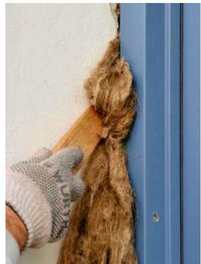
Tjæret værck benyttes til tætning mel- lem ydervæg og vinduer eller døre.
