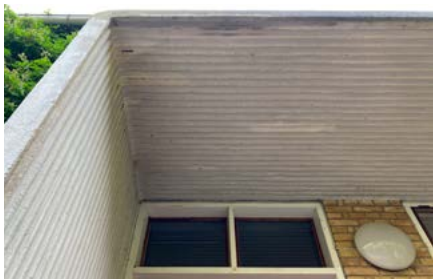
I 1930'erne brugte man ofte betondetaljer over indgangsdøren, fx en vandret eller buet plade, der markerer, hvor døren er og beskytter mod den værste regn. Her er betonpladen udført med riller som en ekstra lille detalje.
