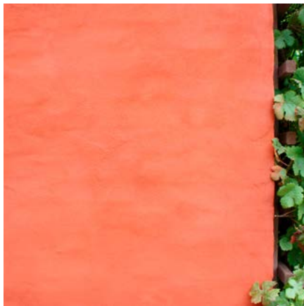
Den mest almindelige behandling var berapning, hvor stenenes kontur kan ses bag ved pudslaget og kalkfarven.
