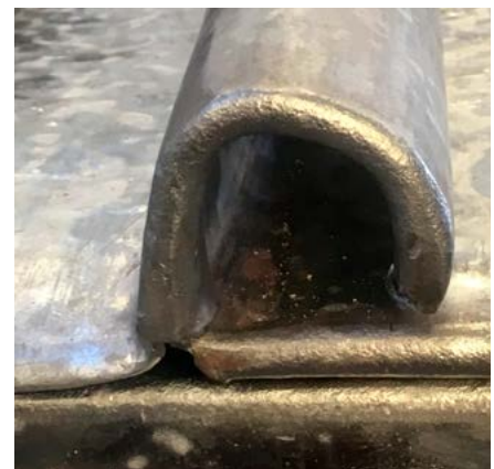
Nyt blytag med runde halvåbne false, blypladerne blev importeret fra England og er altså ikke omsmeltet. Sorø Klosterkirke.
