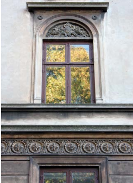
I 1880'erne var facaden og de mange dekorationer som refendfugning, trukne gesimsbånd og indfatninger udført i dækkende puds indfarvet med sand. Dertil kom ornamenter i indfarvet cement.
