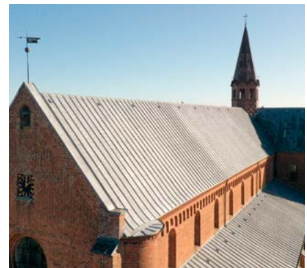
Tagplader af bly blev traditionelt omsmeltet i en såkaldt digel, støbt i en træramme og rullet sammen inden oplægning.
