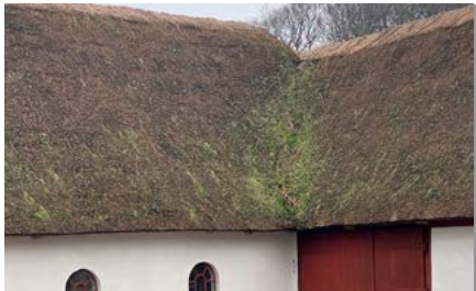
Stråtag med hollandsk eller »syet« mønning blev især anvendt på Lolland og Falster.
