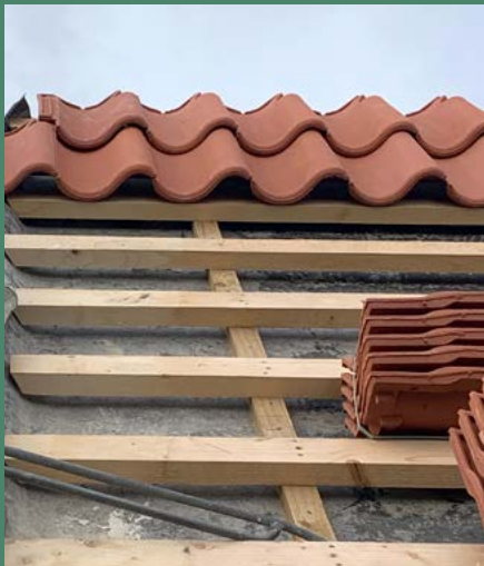
Faste undertage af brædder med pap giver en skivevirkning, som gør taget meget stabilt – oplægning af falstagsten.
