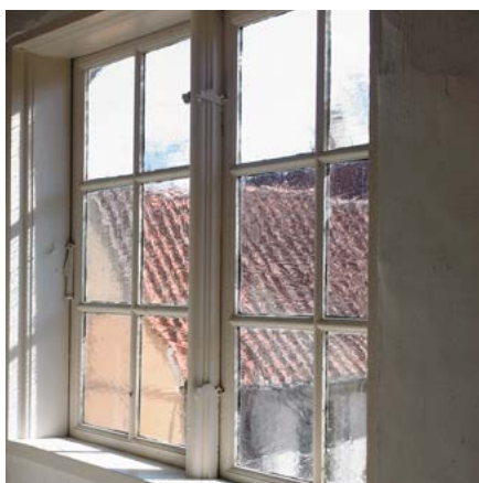
Rudens ujævnhed er karakteristisk for gammelt cylinderglas.
