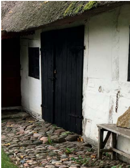
Stråtage har normalt ingen tagrender. Regnvandet drypper derfor direkte ned på jorden langs hele tagskægget. Med en pigstensbelægning langs husmuren undgik man opsprøjt og opfugtning af den nederste del af ydervæggen – en smuk, praktisk – og endda også permeabel belægning.
