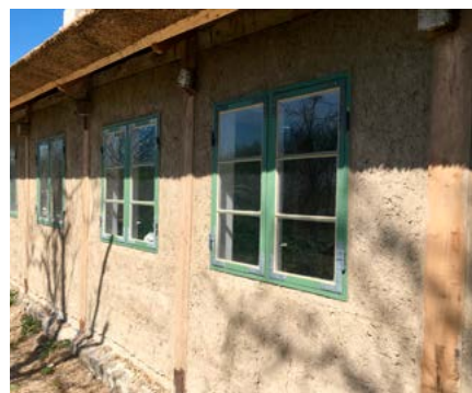
Tavlene er lerklinet på støj, men mangler endnu den afsluttende kalkpuds og kalk på den udvendige side, som skal beskytte lerklining mod at regne væk.
