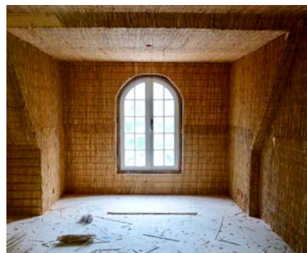
Oprindeligt var mange pudsede lofter og vægge udført på et underlag af forskalling og rørvæv. Hvis huset er fredet, skal denne traditionelle håndværksmetode gentages.
