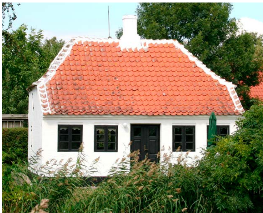
Tegltag med forskælling, udvendig kalket overstrygning. Strynø.
