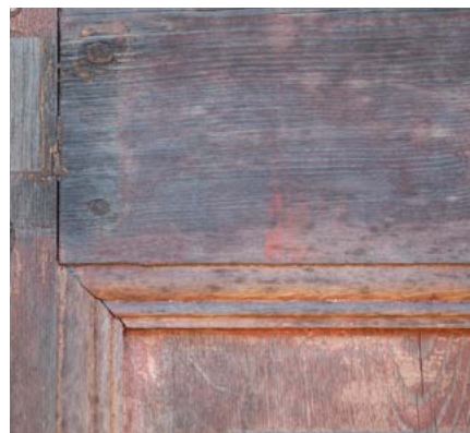
Materialerne udsættes over tid for slid og patina – det er en del af husets identitet og gør det lettere at aflæse husets historie.
