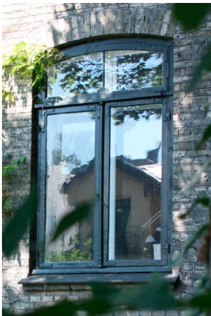
Der er også eksempler, hvor man blander materialerne. Selvom karme og rammer på dette vindue fra 1870'erne er i træ, er både sprossen i overvinduet og lodposten udført i støbejern for at få dem til at se så tynde, elegante og næsten »usynlige« ud som muligt. Sådanne elegante detaljer bør så vidt muligt bevares og istandsættes. I den nederste ramme til venstre er det originale glas bevaret.
