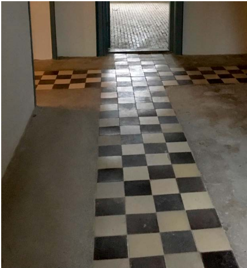
Omkring 1890-1900 ses en del terrazzogulve med indlagte mosaiksten. Det var dengang et ret dyrt gulvmateriale, fordi terrazoen skulle håndslibes.
