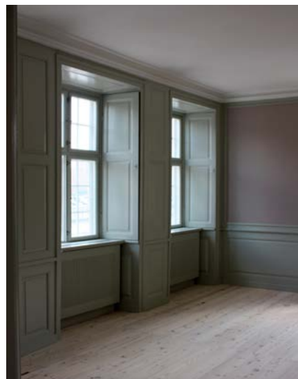
Pillepaneler går fra gulv til loft og var opsat på vinduesvæggen. Panelerne på vinduesvæggen ydede ret stor tætning og var datidens form for isolering.
