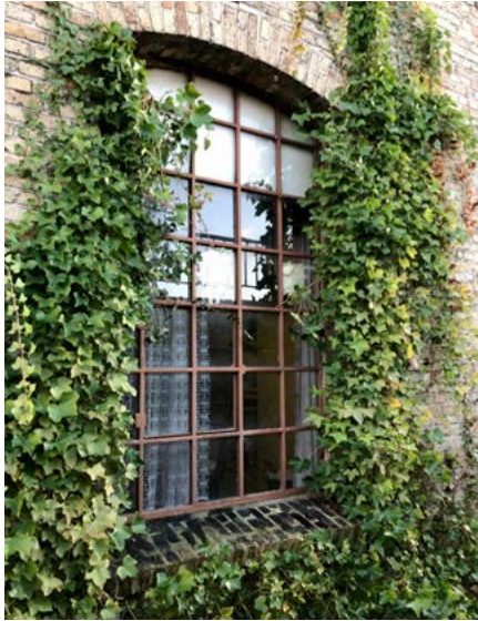
Stort støbejernsvindue med opsprossede ruder på fabriksbygning fra 1870'erne.
