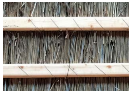
Stråtag set fra den indvendige side med lægter og bindetråd.
