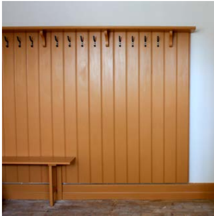
Perlestaf er brædder med fer og not, hvor der er tilføjet et lille halvrundt profil på hvert bræt. Beklædningen får et fint lille reliefmønster.
