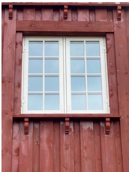
Gavlens træbeklædning står med en-på-to-brædder og er tjæret i den oprindelige rødbrune farve.
