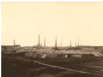
I 1860'erne opstod der overalt i landet store teglværker med ringovne, hvor man fremstillede maskinsten, der var billigere end de håndstrøgne sten. Nye brændingsteknikker gjorde murstenene hårdere med en mere ensartet kvalitet. Teglværkerne kunne nu levere sten til periodens hektiske byggeri.
