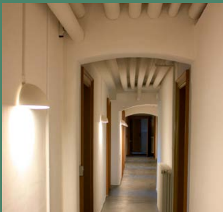
Kælderens slidte betongulv blev malet gråt i forbindelse med en istandsættelse. Alle rørføringer blev fornyet, og de synlige rør omviklet med lærred, som evt. kan males.
