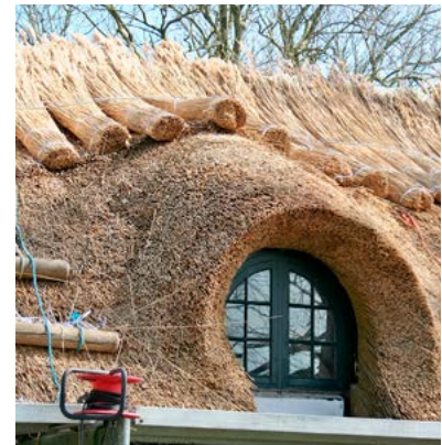
Stråtaget er ved at blive udskiftet. Et helt nyt stråtag har en helt særlig karakter.
