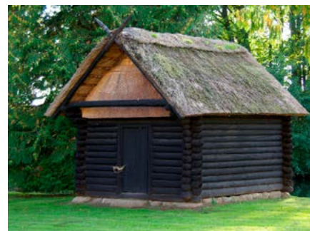
Laftehus efter norsk teknik, hvor vandrette tømmerstokke laftes, dvs. indfældes i hinanden ved hjørnerne.
