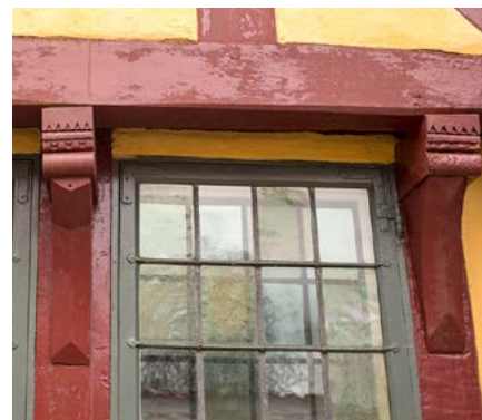
Vindue med spinkle trærammer og blysprosser. Sådanne vinduer var typiske langt op i 1700-tallet, hvor overgangen fra bly til træsprosser skete ganske langsomt.
