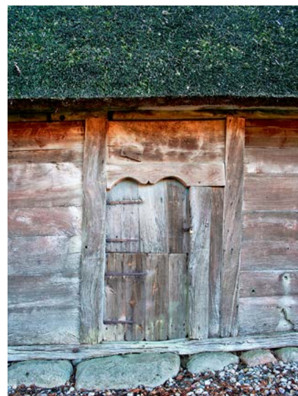
Bulhus med de karakteristiske brede vandrette planker.
