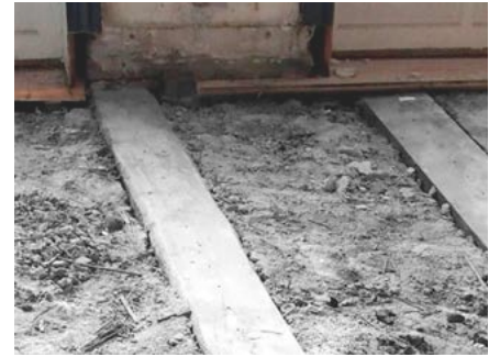
Bjælkelag med indskud af ler var en måde at brandsikre etagedækket.
