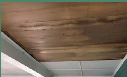
Et nyere pladeloft, opsat i 1970'erne, blev fjernet for at få det gamle bræddeloft frem.
