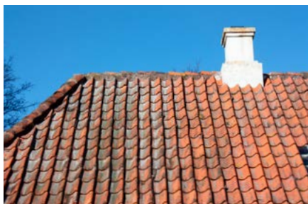
Vingeteglens dybe svaj, bølgevirkningen, er et af dansk bygningskulturs typiske kendetegn. Rygninger og grater var altid murede.
