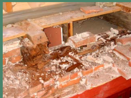
I forbindelse med tagomlægninger er der typisk rådangreb på spær- og bjælkeender.
