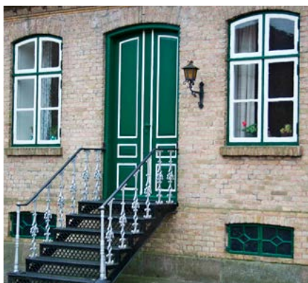
Et tidstypisk træk fra 1880'erne: både trap- pens trin og gelænder er udført i støbejern.
