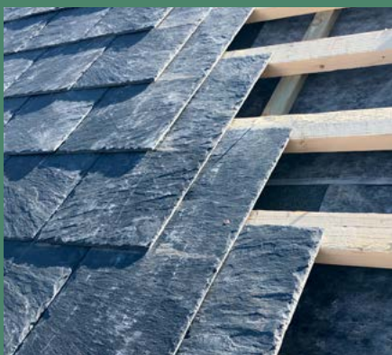
Ved udskiftning af skifertage bør man holde sig til naturskifer – og nye skifersten bør ligne de oprindelige mest muligt i dimension, farve og oplægning.
