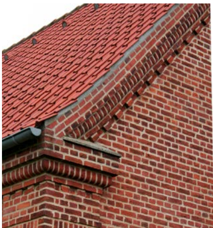
Gavl med markeret omløbende og fremtrukken sparrenkopgesims. Tagstenene er blot lige antydet over gavlkanten.
