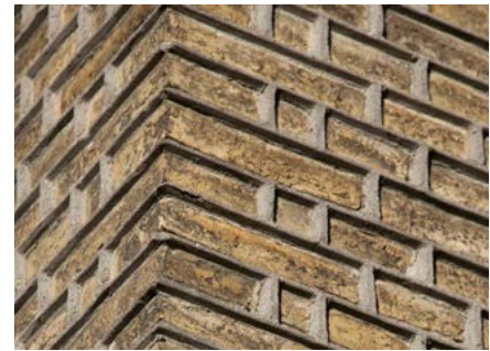
Hamborgfugen, en tidligere variant af de fremstående fuger, er mere kantet. Fugetypen ses især på senklassicistiske huse.
