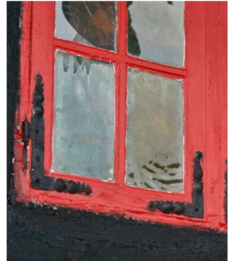
Det trukne glas var ofte tykkere forneden end foroven.
