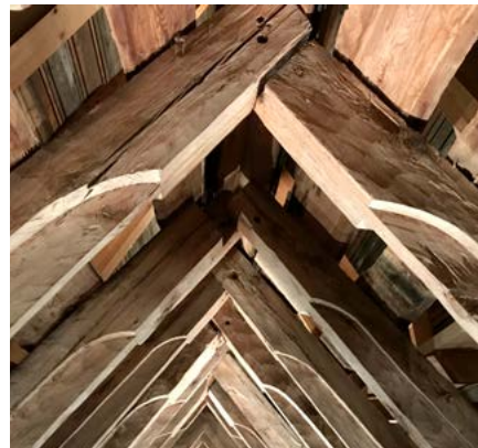
Tagkonstruktionen har traditionelt altid været udført i træ. Middelalderligt tagværk i eg.
