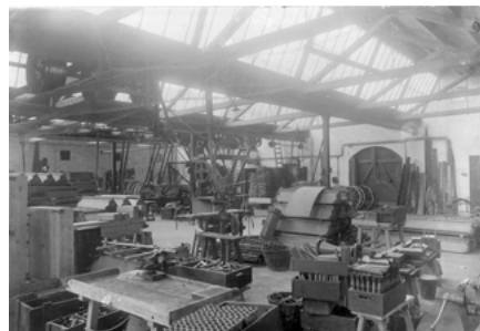
Fra 1870'erne og frem kunne man nu på maskinsnedkerierne hurtigt fremstille fint profilerede vinduer.
