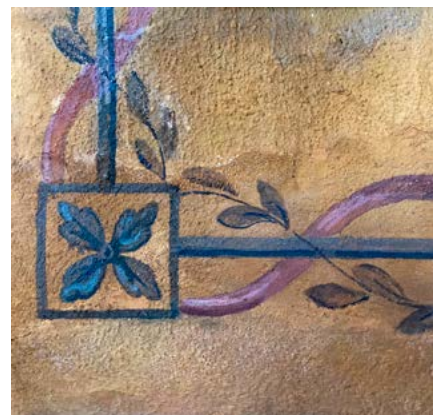
Man malede ofte direkte på pudsen og malede derefter dekorationerne efter fortegninger.
