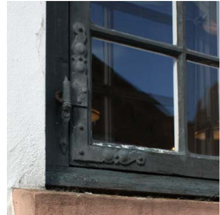
Fint dekoreret, håndsmedet hjørnebåndshængsel med rumpestabel på et hus fra omkring 1800.
