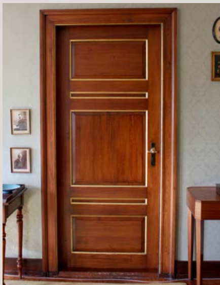
I nybarokken 1900-1925 og Bedre Byggeskik 1915-1940 havde fyldingsdørene et hav af forskellige inddelinger. Typisk havde snedkernes profilsæt hver deres lokale særpræg.
