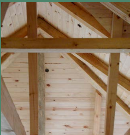
Indvendig side af nyt undertag af brædder.
