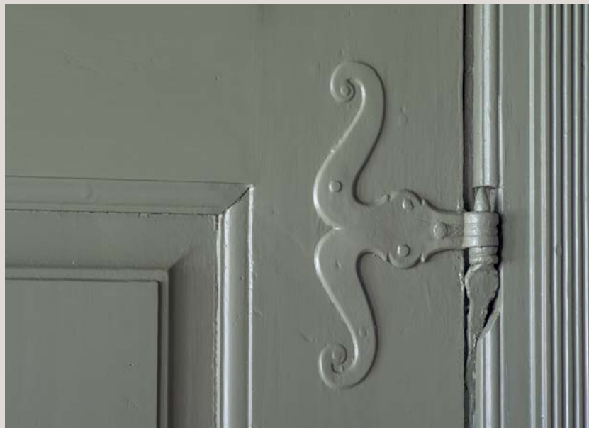
I nybarokken 1900-1925 og Bedre Byggeskik 1915-1940 havde fyldingsdørene et hav af forskellige inddelinger. Typisk havde snedkernes profilsæt hver deres lokale særpræg.
