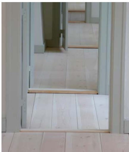
De tidlige maskinhøvlede brædder var ofte udført med fer-fer eller not-not, hvilket gav et gulv med skiftevis brede og smalle brædder. Brædegulvet er fornyet, men udført som oprindeligt.
