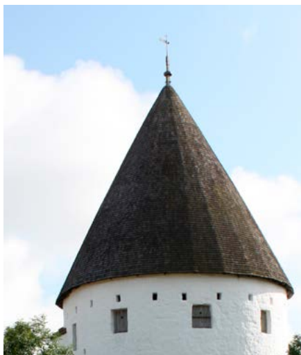
De kegleformede tage på de bornholmske rundkirker er beklædt med spejkløvede egespån, der behandlet med trætjære kan holde i mere end 200 år.
