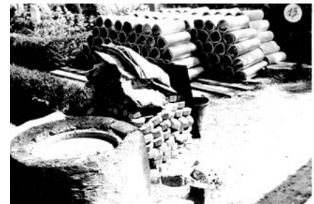
Tagplader af bly blev traditionelt omsmeltet i en såkaldt digel, støbt i en træramme og rullet sammen inden oplægning.
