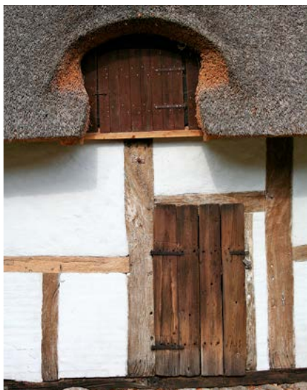
Simpel revledør i udlænge.
