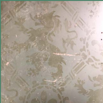
Efter afrensning af eksisterende malingslag kom det oprindelige, oliemalede skabelonmønster frem.
