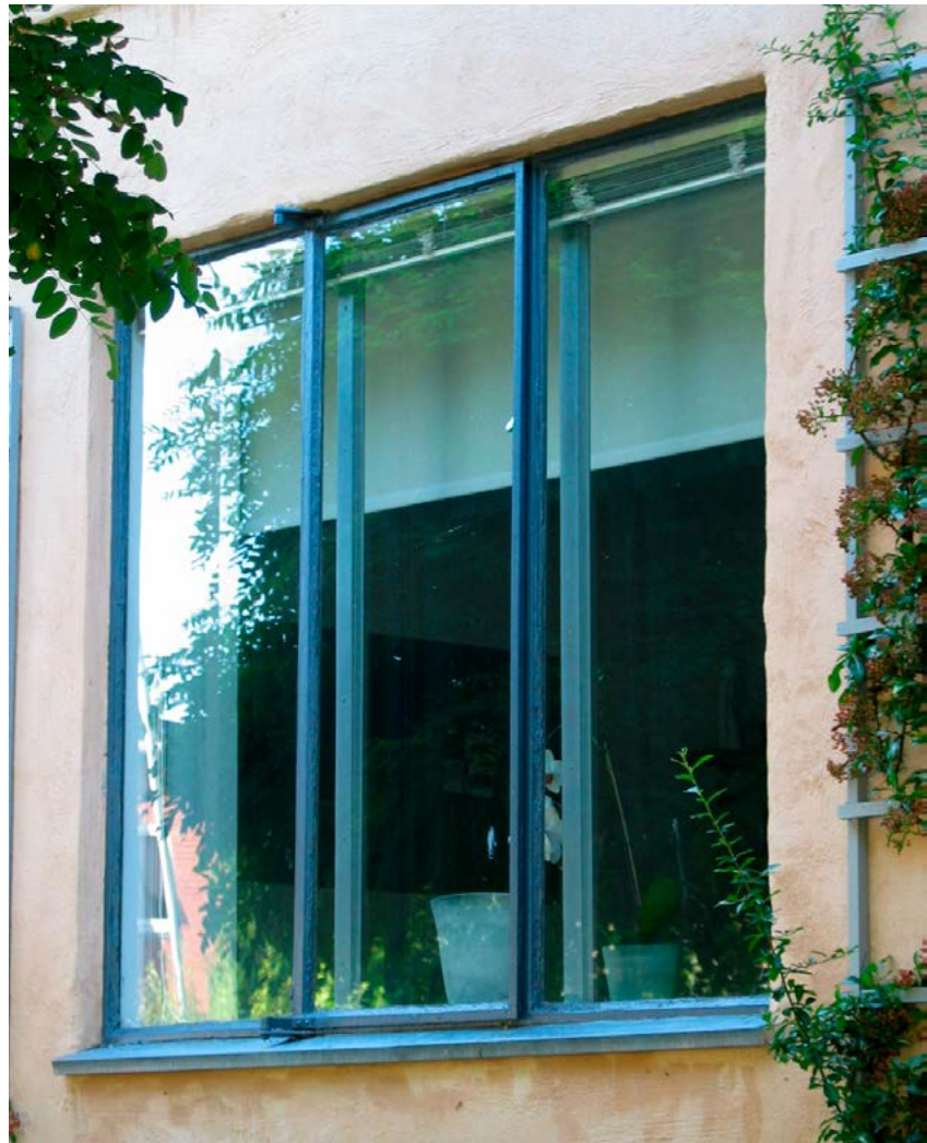
De elegante vinduer i stålprofiler tillod meget tynde og smalle dimensioner på karm og ramme, men kræver en del vedligeholdelse, fordi stålet kan ruste pga. kondens.
