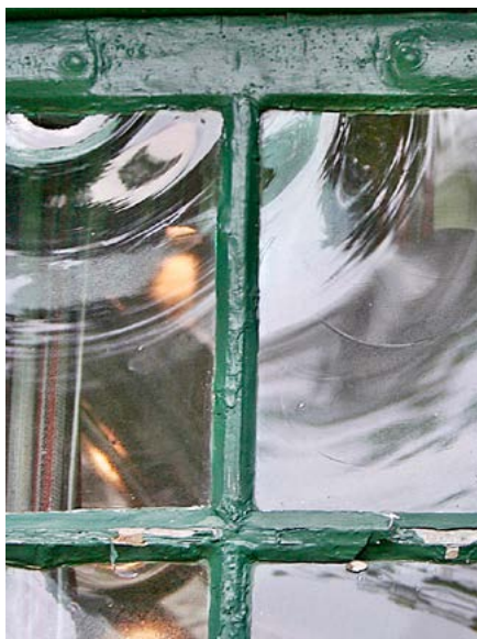
Kronglassets inderste tykke "krone" blev ofte også brugt til mindre ruder i fx døre (øverst). De originale vinduer har beholdt det gamle kronglas med ringe, der flimrer smukt (nederst).
