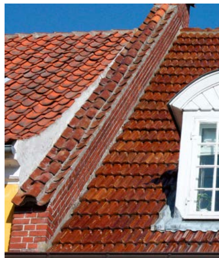
Et eksempel på egnsbyggeskik: på Præstøegnen ses de brune glaserede romertegl, som man brugte omkring 1890 i den nationalromantiske periode. Her er man gået hele vejen med en variant af middelalderens »munke og nonner« på gavlkammen.
