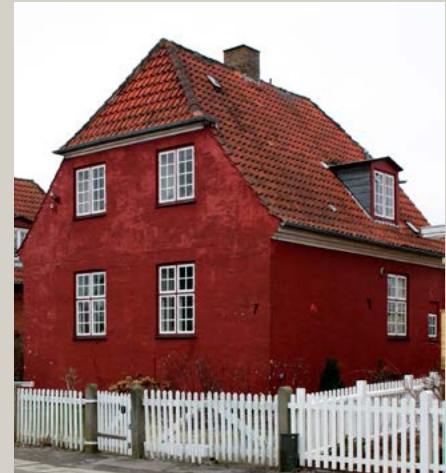
I Bedre Byggeskik-perioden opstod den klassiske, kompakte hustype »murermerstervillaen« med enkle og fint udførte detaljer, halvvalm og symmetrisk gavle.
