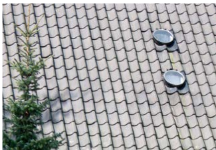
Blådæmpede tagsten fremstilles ved, at en almindelig rød eller gul tagsten får yderligere en brænding ved meget lav ilttilførsel. Blådæmpningen gennemfarver tagstenene og fremhæver samtidig tagstenenes farveforskelle.
