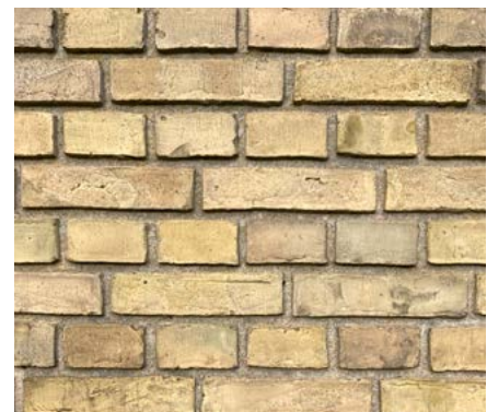
Krydsforbandtet har været et af de mest brugte gennem tiden.
