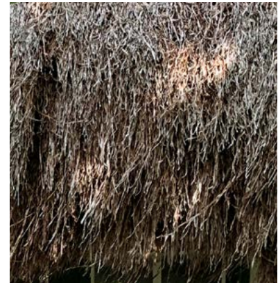
Tang blev tidligere anvendt til isolering og polstring.
