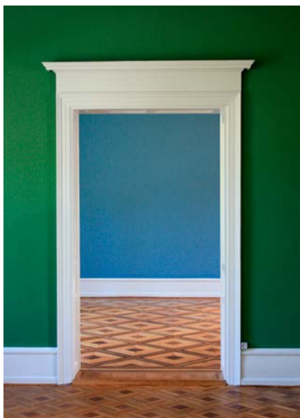
I finere huse kan nogle parketgulve være udført med intarsia, hvor små stykker af træ i en mørkere træsort blev indlagt i parketten, så der dannedes mønstre. Historicistisk interiør fra 1872.
