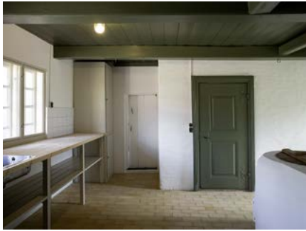
Kalkede vægge reflekterer lyset og afsmitter ikke, hvis behandlingen er udført korrekt. Kalkmaling er normalt fuldt vaskbar med rent vand og milde rengøringsmidler.
