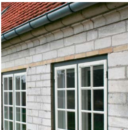
Grundmur opført i udskårne kridtsten, bloksten, fra Stevns. St. Heddinge Præstegård.
