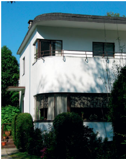
Her er mange af de typiske detaljer samlet i én villa: Udkragende beton over hoveddøren, hjørnevindue på 1. sal og et buet vindue i stueetagen under en buet altan med et gelænder, der giver mindelser om ocean-damperens ræling. Skovbrynet, Århus.
