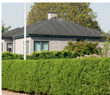
Trekantlister o. lign. bør principielt ikke anvendes, da de vil give taget en reliefvirkning, der ikke hænger sammen med periodens ideal om homogene flader.
