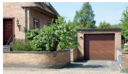
Havemuren er opført i samme murværk som huset og garagen.
