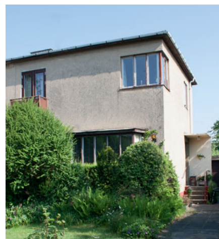
En grovpudset overflade giver facaden tyngde.
