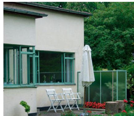
På siden af terrassen er monteret en læskærm i et af tidens nye materialer, råglas.
