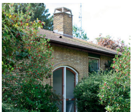
Tag af eternitplader, der giver en plan tagflade.
