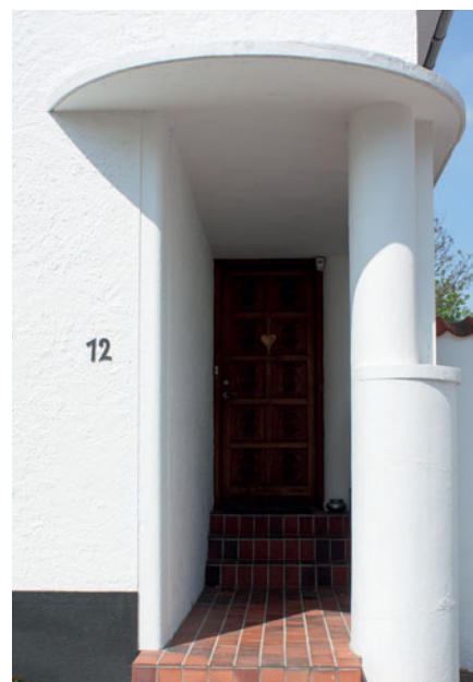
Indgangspartiet er markeret af en betonplade, der buer omkring facadens hjørne.
