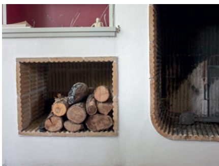
Både pejseåbningen og rummet til opbevaring af brænde er udført af rillede hårdbrændte tegl.
