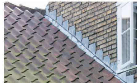
På huse opført med forskudte bygningskroppe er inddækningen mod gavlen ofte udført i zink i en såkaldt »musetrappe«.
