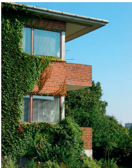
Altanværnet er udført i samme røde murværk som facaderne, og der ligger stålprofiler udfyldt med mursten over hjørnevinduerne.
