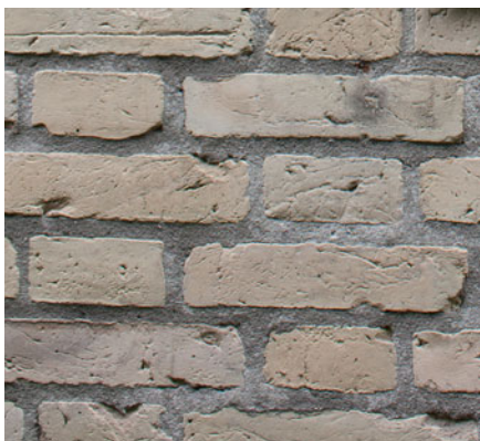
De blødstrogne gule mursten var de mest brugte og giver sammen med skrabefugerne en ensartet overflade, der er i fin overensstemmelse med funktionalismens idealer om fladevirkninger.
