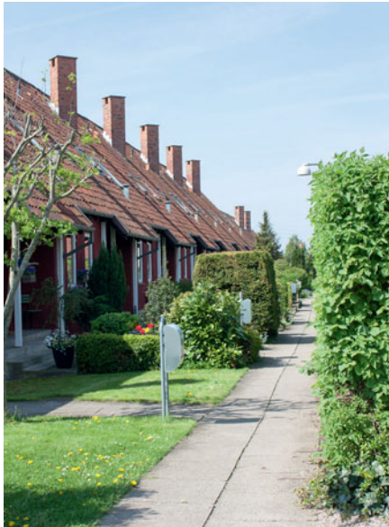
Rækkehusenes længeform brydes ofte af såkaldte udskud. Taget er ført ud over den lavere forskydning, der fx kan indeholde et bryggers eller som her et overdækket indgangsparti. Rækkehusbebyggelse i Odense.
