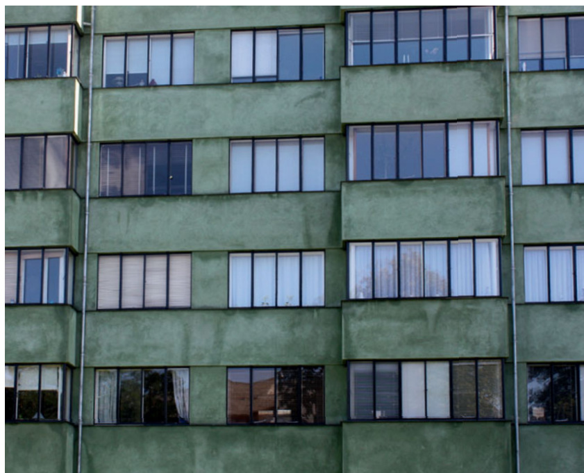
»Det grønne funkishus«, opført 1930 af arkitekt Hans Dahlerup Berthelsen. Bygningen, der i dag er fredet, er det første etageboligbyggeri i Danmark med en bærende stålskelet-konstruktion indmuret i facaderne. Jernvinduerne er malet mørke, så de slanke karme og rammer syner af endnu mindre. Nordre Fasanvej, Frederiksberg.
