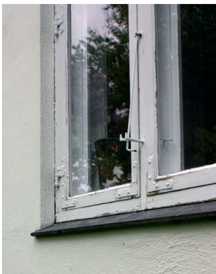
Et helt traditionelt vindue i træ med hjørnebåndshængsler og forsatsramme på en funkisvilla fra 1935 i provinsen – man var altid lidt længere om at tage de nye idéer til sig ude på landet end i de større byer.
