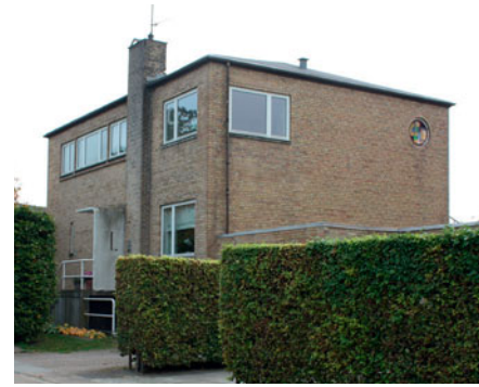
Den toetages villas lave tagpaptag er afsluttet helt knapt. Her er det blot tagrenden af kobber, der danner overgang til facaden.
