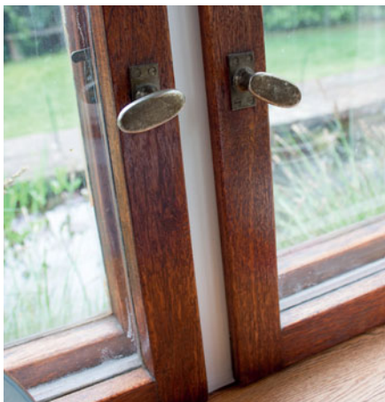
Der er ingen grund til at skifte glasset i forsatsrammerne ud med to-lags termoglas – isoleringsevnen er lige så god med et-lags energiglas, som kan monteres i de oprindelige rammer. Det afgørende er, at forsatsrammerne slutter helt tæt.
