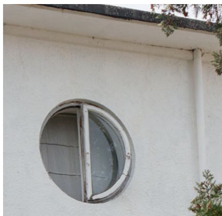
Det elegante tagudhæng er pudset på undersiden, og taget er afsluttet ved at føre tagpappen ned over tagkanten. Der er indbyggede tagrender og synlige nedløbsrør.
