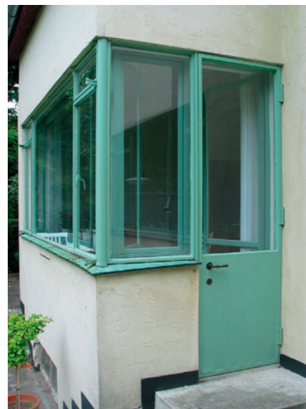
Havedøren er en forholdsvis smal enkelt-fløjet jerndør med et dørgreb i messing. Bemærk, at der både er forsatsrammer for vinduerne og døren.
