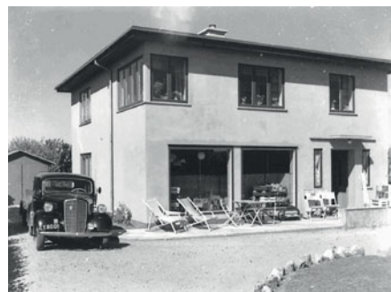
Funkishuset blev opført af et ungt ægtepar i 1934 i en jysk landsby, og den nye moderne arkitektur har ganske givet været opsigtsvækkende. Huset blev få år efter opførelsen ombygget, og der blev indrettet en isenkram i stueetagen.
